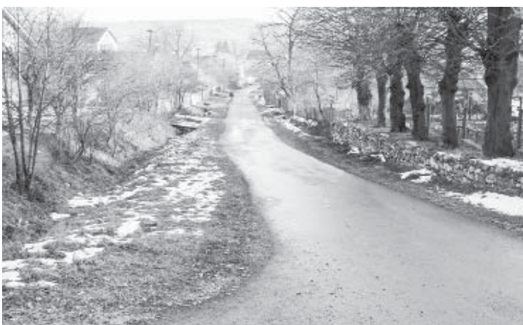
Якісно відремонтована дорога по вулиці Євгена Коновальця
