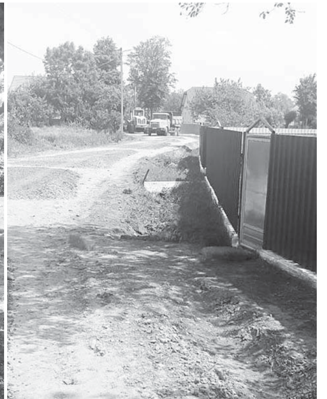
Ремонт дороги. 2019 р.
