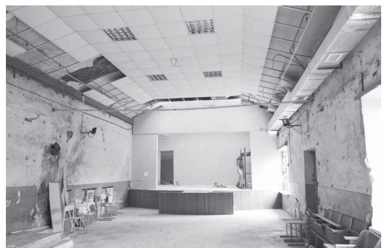
У Будинку культури ремонт повним ходом
