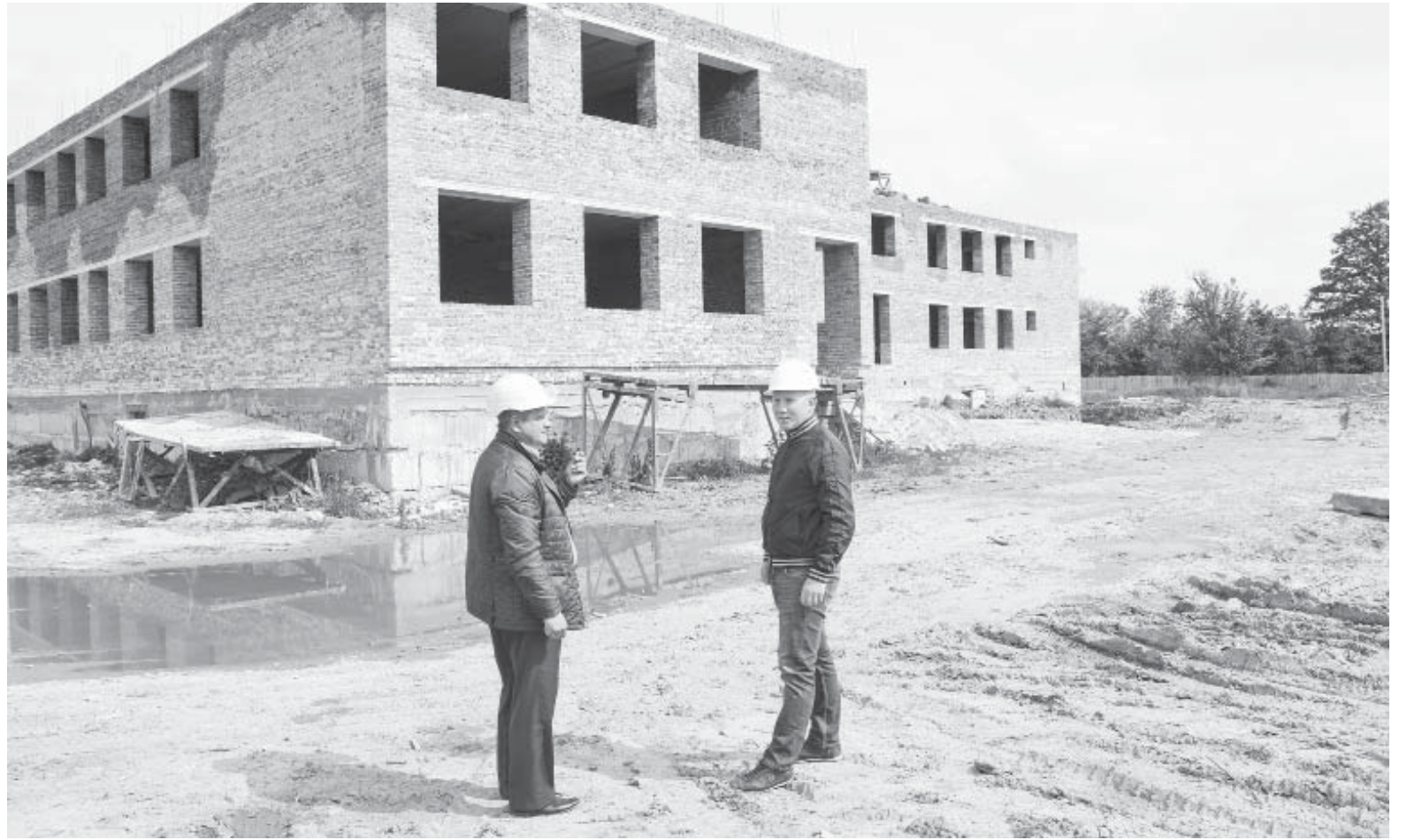
На будівельному об'єкті НВК М. Курій та Ю. Левків
