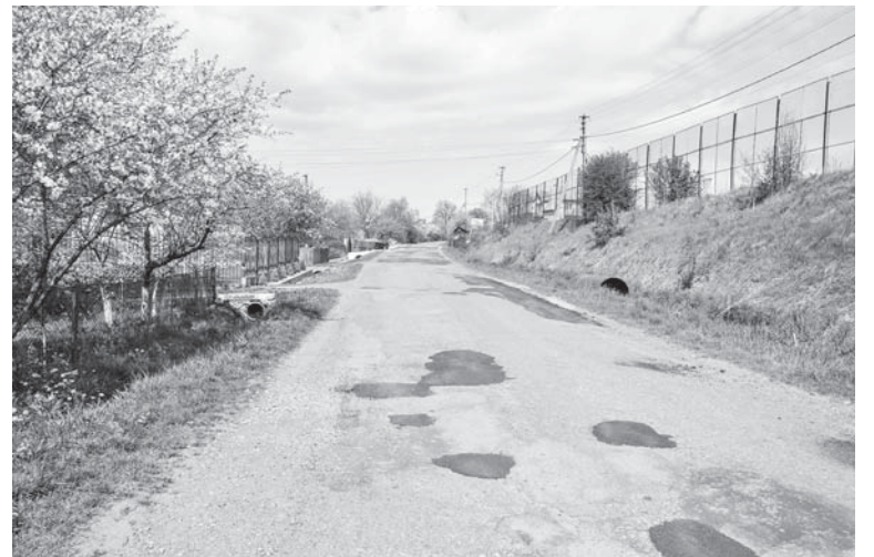
Вулиця Незалежності після ямкового ремонту
